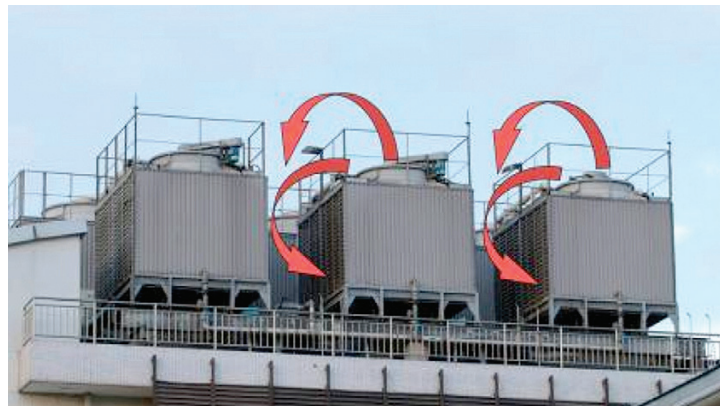
GAMBAR 18 Penempatan Menara Pendingin yang Kurang Optimal
