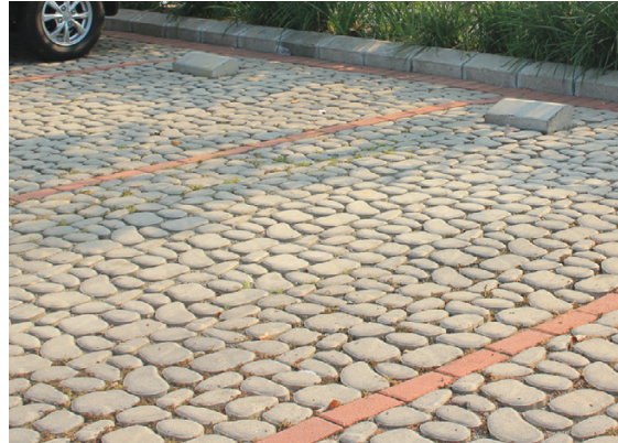
Paving Beton dengan Agregat pada Celahnya 26
